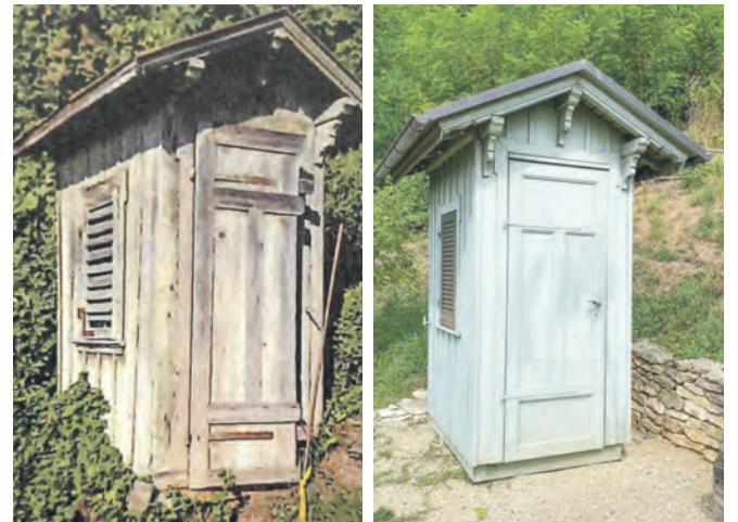
Beispiel eines Rebhäuschens vor der Sanierung (links) und das Rebhäuschen nach der Sanierung.
